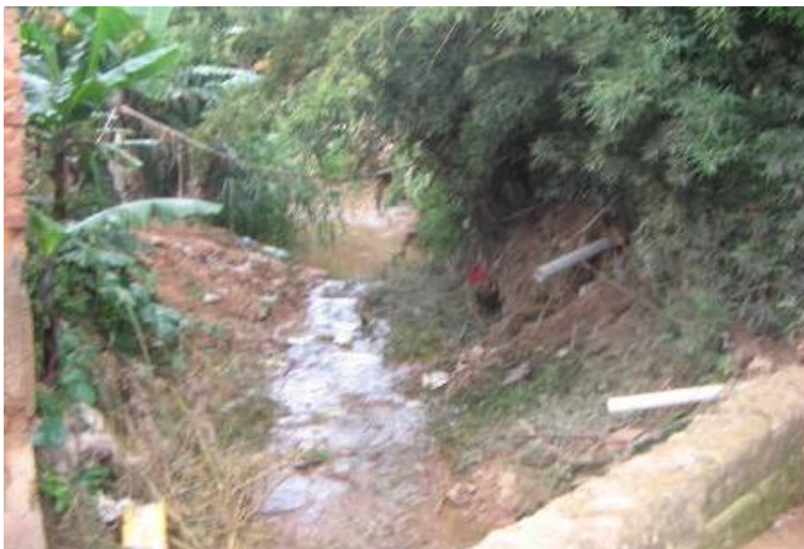
Foto 08 – Esgoto lançado “in natura” no Córrego Bambuzinho.
