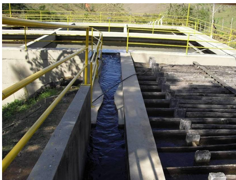
Foto 02 – Calha Parshall para Medição de Vazão.
