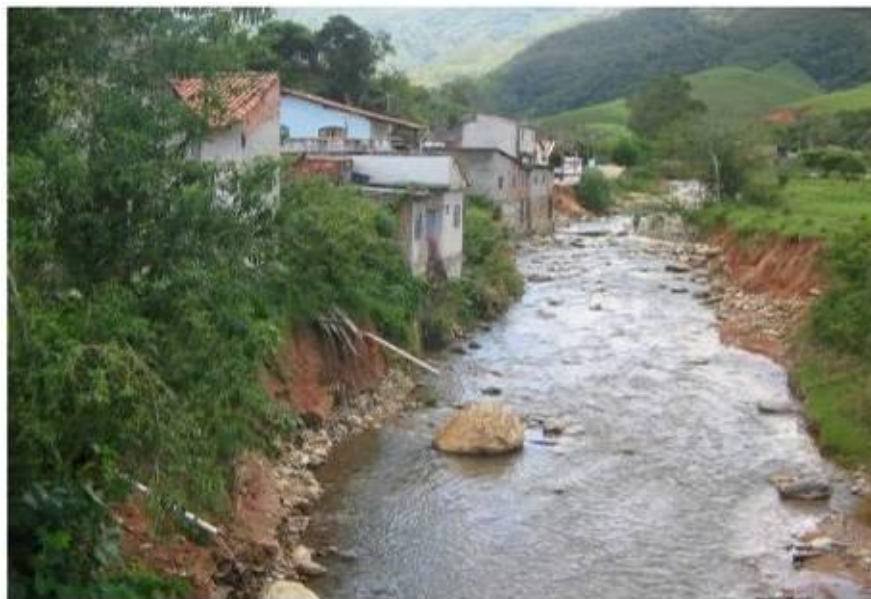
Foto 10 – Esgoto lançado “in natura” no Ribeirão Benfica.
