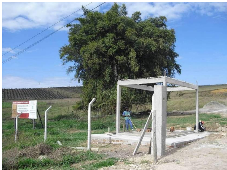
Foto 13 – Portaria da futura ETE de Piquete - em construção.
