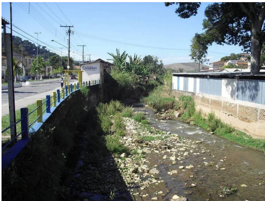
Foto 11 – Córrego da Tabuleta que recebe contribuições de esgoto “in natura”.
