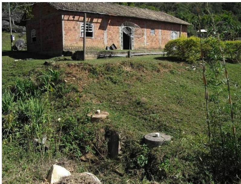
Foto 14 – Fossa Séptica implantada com recursos do FEHIDRO no Bairro Benfica.
