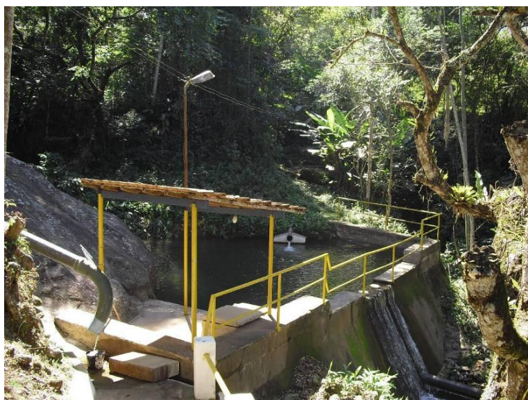
Foto 01 – Barragem de Elevação de Nível no Ribeirão do Prata.
