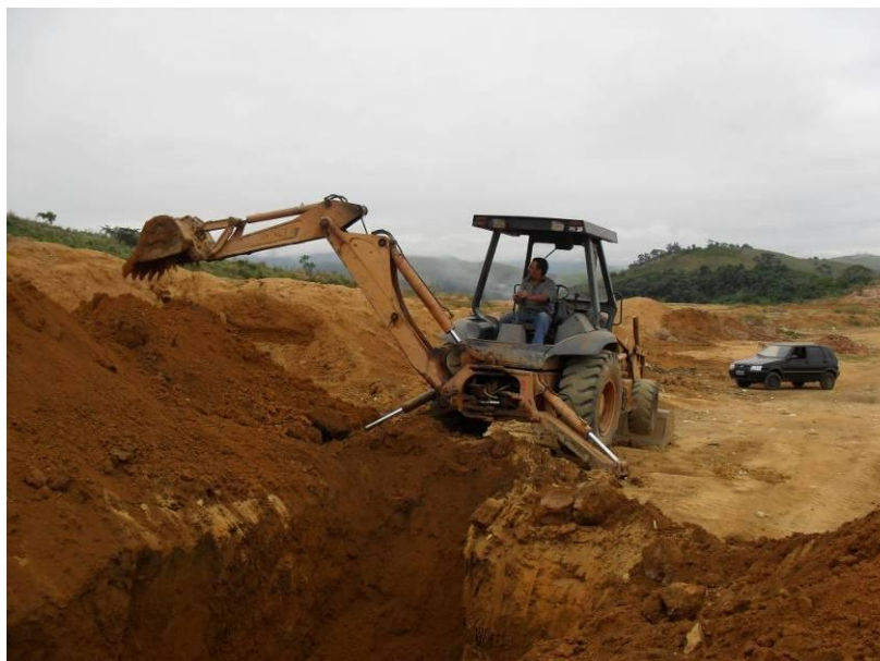
Foto 19 – Operação do Aterro Municipal de Piquete.
