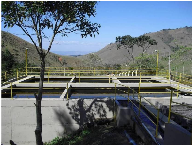
Foto 03 – Decantadores de Fluxo Horizontal.
