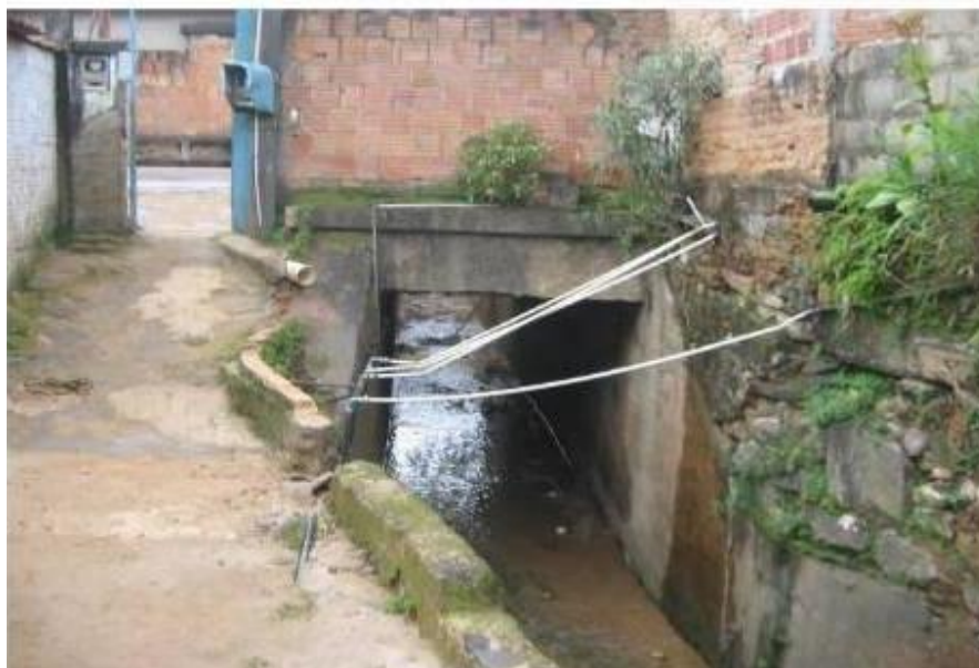
Foto 09 – Esgoto lançado “in natura”, com detalhes das ligações de água.
