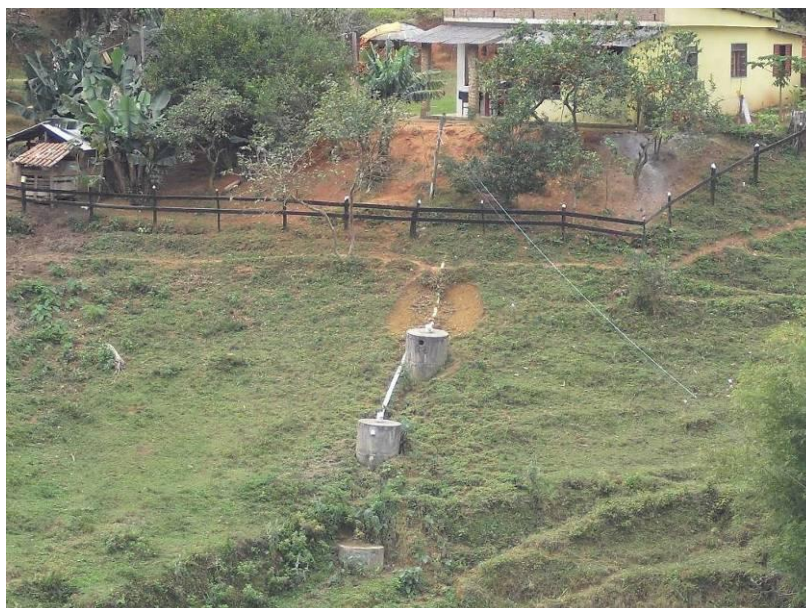
Foto 15 – Fossa Séptica implantada com recursos do FEHIDRO no Bairro dos Marins.
