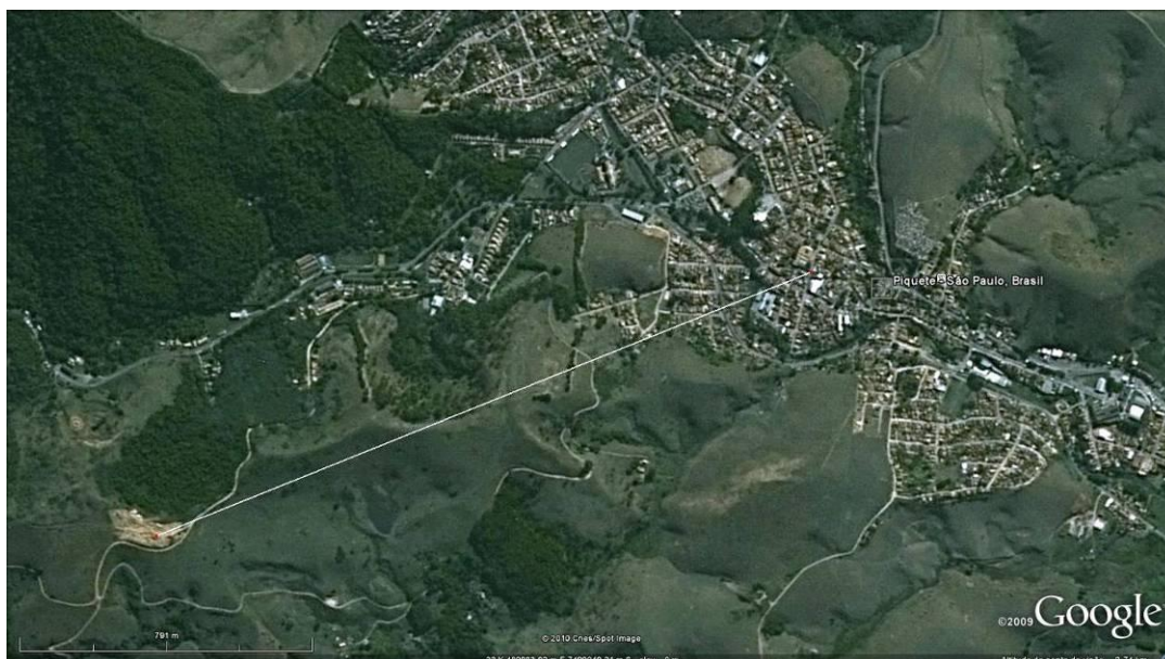
Foto 17 – Distância entre o Aterro Municipal e a Cidade de Piquete (Fonte: Google).
