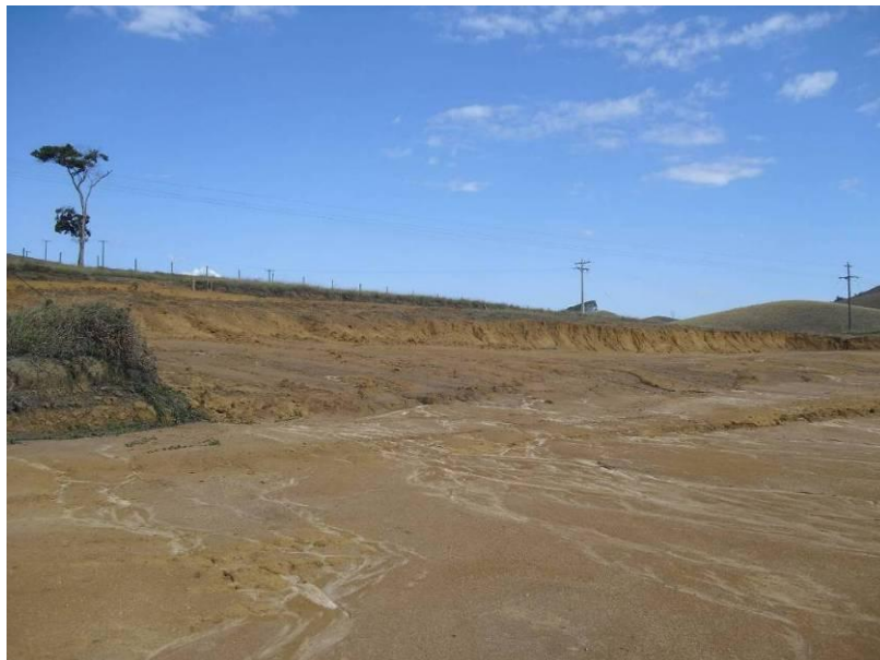
Foto 12 – Área da futura ETE de Piquete - em construção.
