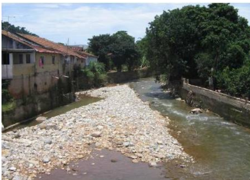
Foto 07 – Esgoto lançado “in natura” no Rio Piquete.
