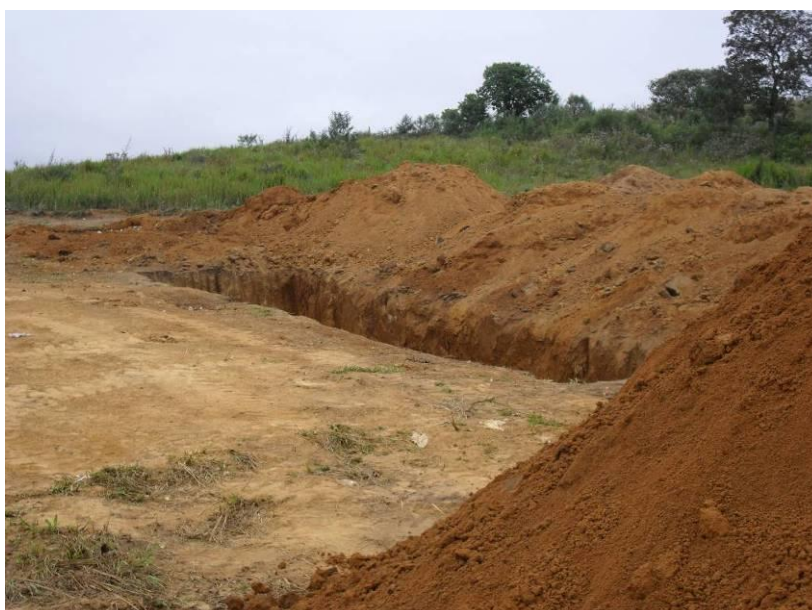
Foto 18 – Vista do Aterro Municipal operado em valas.
