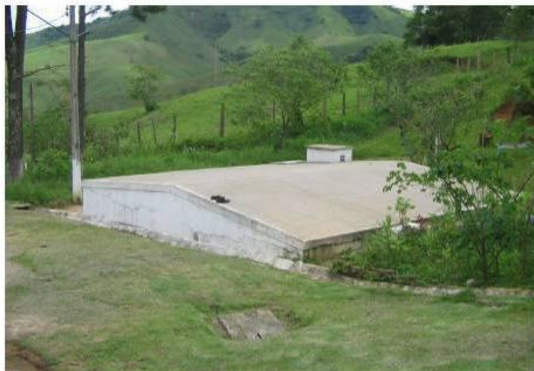
Foto 04 – Reservatório de Água de Lavagem.
